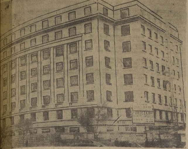
El proyecto que presenta actualmente el magnífico edificio de renta que en Avenida Bulnes esquina de Alonso Ovalle está construyendo la Caja de Retiro de las Fuerzas Armadas
