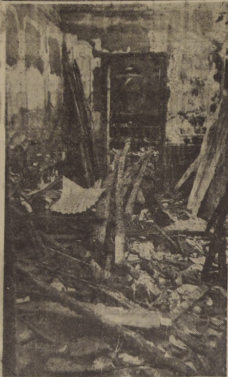
Este es el balance que arrojó el incendio que destruyó ayer la Cooperativa "Antonio Varas" de los empleados de la Caja Nacional de Ahorros. 4.500.000 pesos fue el saldo en pérdidas materiales del siniestro.
