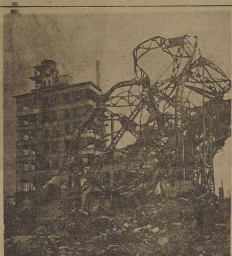
Efectos de la bomba atómica en un rascacielo de armazón de acero, en la ciudad de Hiroshima.
