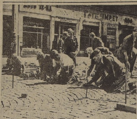
VARSOVIA, Polonia. — Obreros polacos colocan adoquines para reparar la calle de Kruca, que corre paralela a la de Marszałkowska, la principal de esta capital, y que estaba destruida desde la época de la guerra. Estas obras son parte del plan de reconstrucción general de Varsovia. — (Foto ACME).
