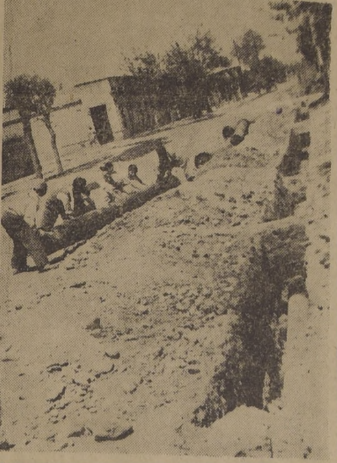
En una de las populosas calles de Quinta Normal se están colocando las tuberías para dar agua potable a miles de personas, que hoy carecen de tan vital elemento. Es la obra conjunta de autoridades y vecinos, digna de imitarse.
