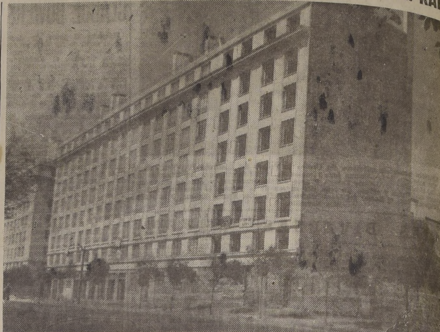
Edificio que la Caja de Empleados Públicos y Periodistas está construyendo en Avenida Bulnes esquina de Eleuterio Ramírez, y que quedará terminado durante el próximo mes de noviembre.
