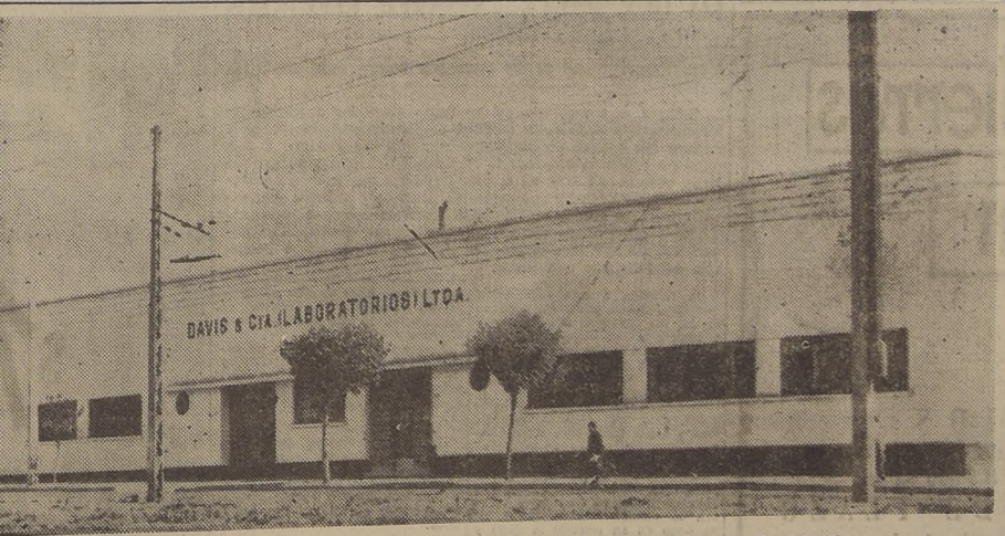
Edificio de Davis y Cia. (Laboratorios), Ltda. en Avenida Presidente Balmaceda N.º 2170-74.
