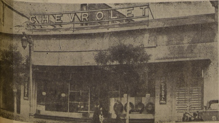
Oficinas de Davis y Cia. (Autos), Ltda. en Alameda Bernardo O'Higgins N.º 1760.
