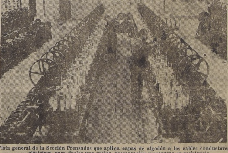
Vista general de la Sección Prensados que aplica capas de algodón a los cables conductores eléctricos, para darles una mejor presentación y asegurar su resistencia.
