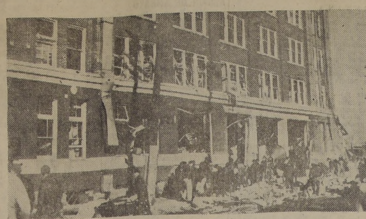
16 OBREROS ENCONTRARON LA MUERTE AQUI.—SIOUX CITY, Estados Unidos.—Dieciséis obreros murieron en la explosión de este frigorífico de cinco pisos de la Swift Company. Ciento una personas tuvieron que recibir tratamiento médico. Los miembros de la cuadrilla de salvamento tuvieron que emplear máscaras de gases cuando ingresaron a buscar las víctimas. La explosión hizo volar ventanas y puertas del edificio, y se creó que se debió a una filtración de gas natural. —(Foto ACME).
