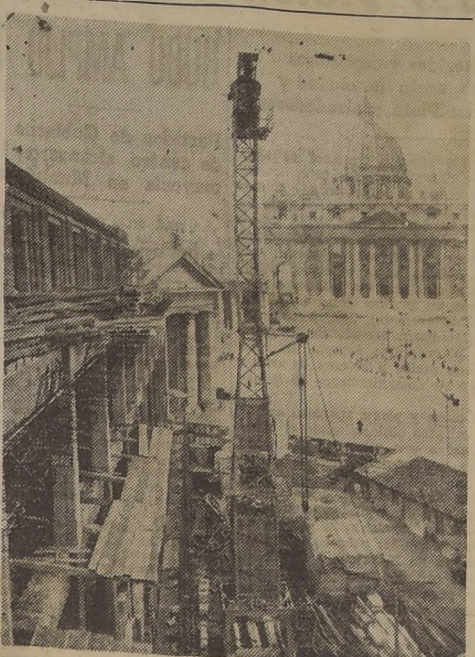
ROMA.— Construcción de un hotel para peregrinos. La capital italiana se prepara para recibir a los miles de peregrinos que la visitarán durante el Año Santo, construyendo nuevos hoteles para alojarlos. Dos hoteles, con habitaciones para 1.200 peregrinos cada uno, se están construyendo al final de la plaza donde se encuentra la Basílica de San Pedro. El hotel que muestra la foto, quedará terminado en el mes de abril próximo. ACME
