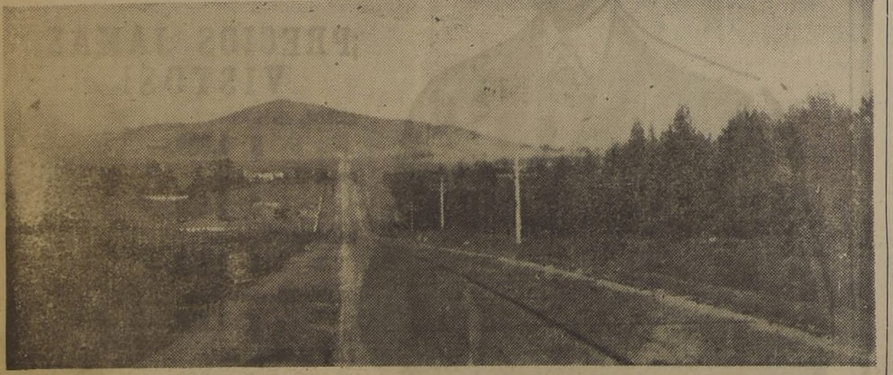
Camino de Mellipilla a San Antonio, totalmente pavimentado y uno de los mejores de la zona central de nuestro país
