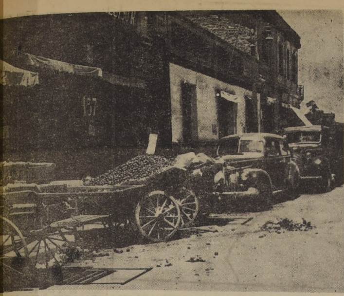
CIUDAD EN LOS ALREDEDORES DE LA VEGA. — Un aspecto de la calle Salas, que da paso a la Vega Central por el sur, mostrando su fisonomía habitual: desorden, suciedad, podridas desamparadas por la calzada, carretones con sus productos expuestos a las heladas, basuras acumuladas días enteros, etc. Los alrededores de este importante centro de abastecimiento de artículos alimenticios, son un atentado a la salud pública. Los lotes que circundan este abastecimiento funcionan en pésimas condiciones de higiene. El NACION denunció esta grave irregularidad a la jefatura sanitaria provincial, la que dispuso de inmediato una visita de los inspectores del distrito correspondiente.
