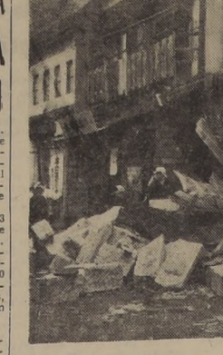
IMAICHI, Japón. — Desde el desastre de Tokio, en 1923, no había ocurrido en Japón otro terremoto peor que el registrado el 28 de diciembre, el que causó la muerte de ocho personas y destruyó 874 casas, según un comunicado oficial. Alrededor de 5.170 casas quedaron parcialmente dañadas por la serie de temblores. Donde los daños fueron mayores fue en Imaichi. El 80 por ciento de las casas de esta localidad quedó dañada, según se puede ver en esta fotografía. — (Foto ACME)
