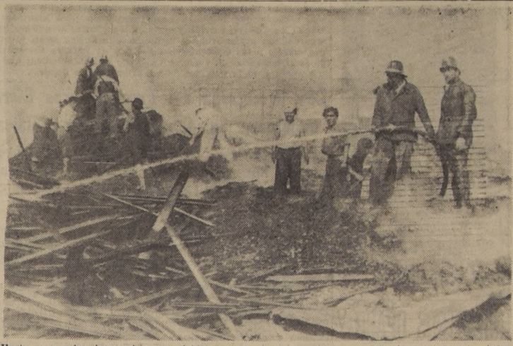
Hasta avanzadas horas de ayer, debieron trabajar los bomberos para dominar totalmente el fuego de la barraca de la calle San Eugenio, donde las llamas ocasionaron daños por 12 millones de pesos. La fotografía muestra elocuentemente los perjuicios ocasionados por el siniestro.
