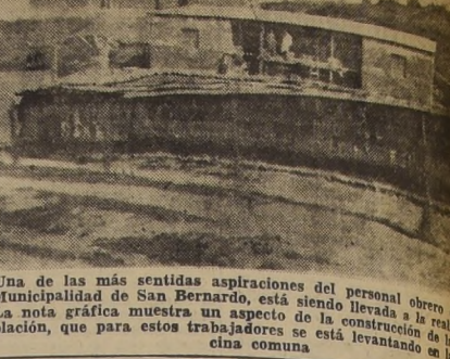
Una de las más sentidas aspiraciones del personal obrero de la Municipalidad de San Bernardo, está siendo llevada a la práctica. La nota gráfica muestra un aspecto de la construcción de una casa comuna
