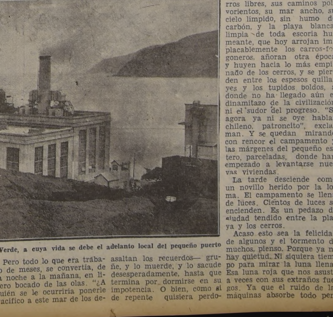
Planta termoelectrica de Laguna Verde, a cuya vida se debe el adelanto local del pequeño puerto
