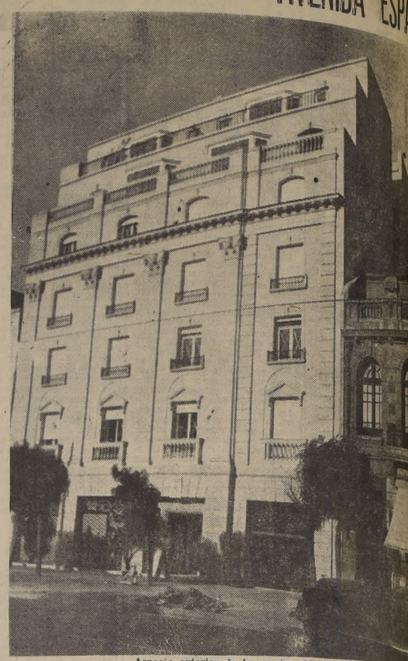
Aspecto exterior de la construcción
