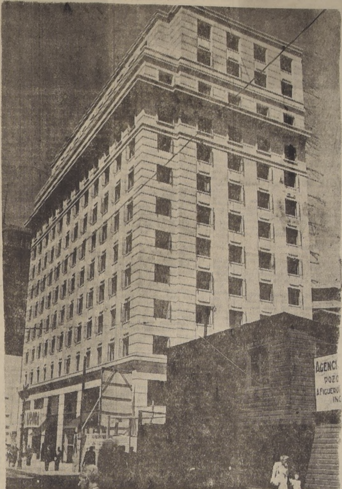
Está terminándose el nuevo y magnífico edificio que la Sociedad Anónima "Progreso Urbano" ha construido en Ahumada 132 al 154. En el grabado, un aspecto de la magnífica construcción.
