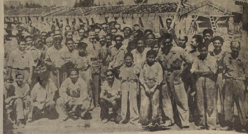
S. E. DEPARTO CON LOS OBREROS SERENENSES.— Entre las numerosas visitas que realizó el Primer Mandatario el día de ayer en La Serena, cabe destacar la efectuada a la población que construye la Caja de los Ferrocarriles del Estado, que tendrá veinte viviendas para el personal, con cuatro dormitorios cada una y muy confortables. En esta oportunidad, S. E. impartió terminantes instrucciones para que las casas quedaran terminadas a más tardar dentro de dos meses.
