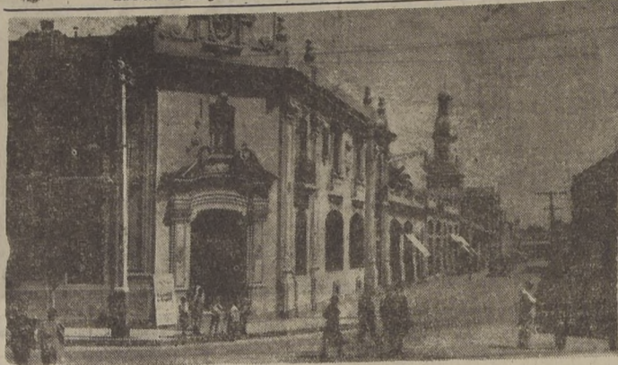
Edificio de la Caja de Ahorros de La Serena.
