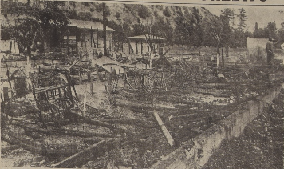
LAS RUINAS DE DOS PABELLONES. — Esto fue todo lo que quedó de los dos pabellones que se incendiaron ayer en el Politécnico "Alcibiades Vicencio", en San Bernardo. Al ocurrir el siniestro, sólo había 95 niños de la dotación normal de ciento veinte. Debido a los esfuerzos desplegados por los inspectores y alumnos mayores, en los primeros instantes de pánico, la tragedia se limitó a un muchacho muerto y a seis heridos.
