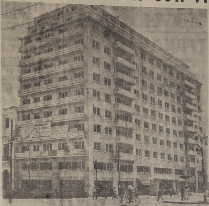
Aspecto del nuevo y magnifico edificio que la sociedad Claras y Cia. ha levantado en Mac-Iver esquina de Alameda, formando una ampliación del centro comercial de Santiago
