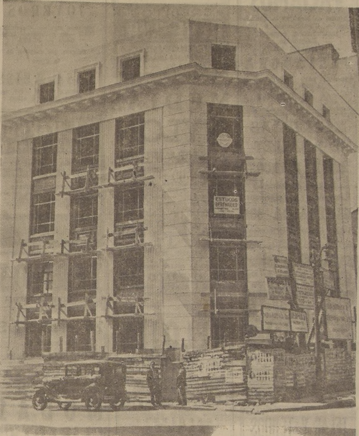
Edificio que en Agustinas con Amunátegui, está terminando de construir la Braden Copper para sus oficinas
