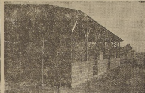
Edificio principal del polígono de Talagante.—Aquí están también el "stand" de tiro y los almacenes en que se guarda el armamento
