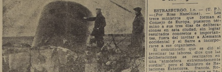
Llega a su fin la demolición de las fortificaciones de la Línea Siegfried, en el sector ocupado por las fuerzas de Francia.
