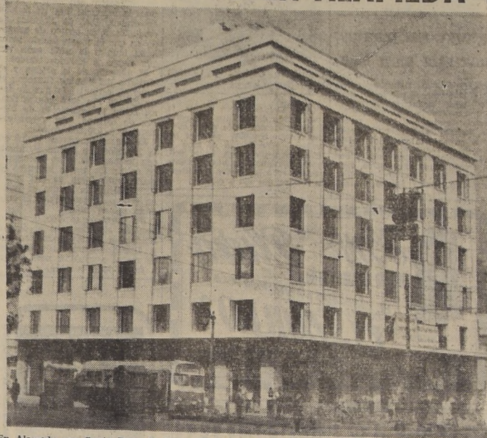
En Alameda con Santa Rosa, la firma "Neut Latour" ha terminado la construcción de un magnífico edificio que pertenece al señor Juan Said.—Arquitectos fueron los señores Carlos Cruz Eyzaguirre y Escipión Munitzaga.
