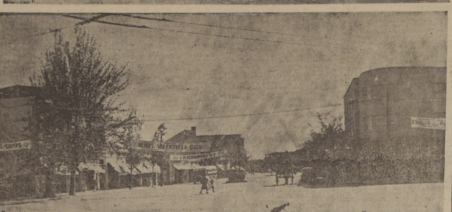
Santiago se "descentraliza" hacia los barrios apartados. En Providencia, Ñuñoa, San Miguel, Quinta Normal, surgen permanentemente nuevos establecimientos comerciales e industriales...
