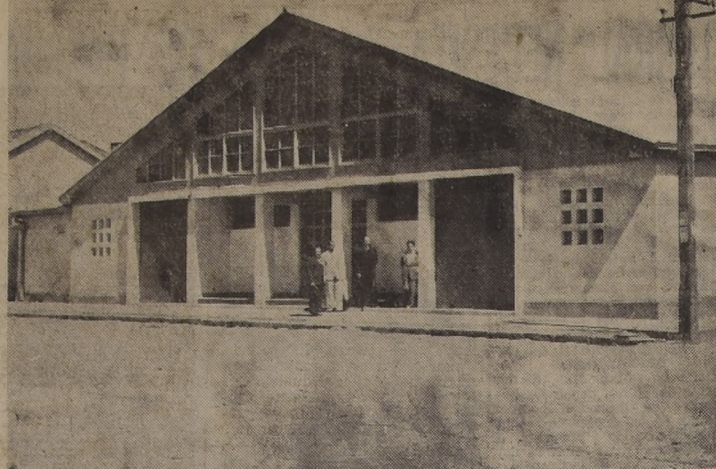
El Mercado Municipal es una de las construcciones nuevas y modernas de Mulchén. No puede decirse lo mismo de la Cárcel Pública, cuyo ruinoso estado constituye un verdadero peligro...
