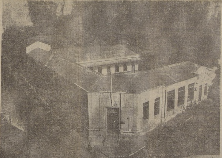
LA DEMOLERAN PARA AISLAR EL CERRO SANTA LUCIA.— El total aislamiento del cerro Santa Lucía, obra que figura en los planes de heroseamiento de este paseo público que se ha trazado el Alcalde, requiere la demolición de los edificios que colindan con el cerro por el lado oriente. Uno de estos inmuebles es el ocupado por la Escuela de Desarrollo, dependiente del Ministerio de Educación, cuyo traslado a otro lugar depende de un estudio que están realizando en conjunto el jefe comunal con el Ministro Leighton.
