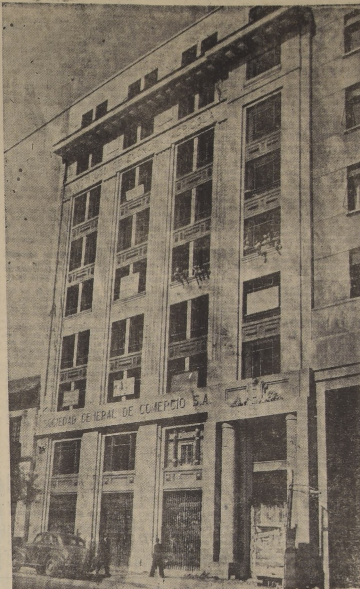
Aspecto que actualmente presenta el nuevo edificio que en Avda. Bernardo O'Higgins 1164 se ha construido para el Instituto de Economía Agrícola y la Sociedad General de Comercio.
