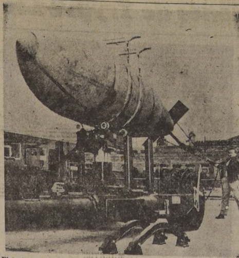
Elevadores portátiles para bombas, con capacidad para levantar bombas de 25 toneladas a una altura de 125 pies sobre la tierra, por la Boeing Aircraft Company, en Wichita, Kansas. Estos elevadores están equipados con motores eléctricos que funcionan con el sistema hidráulico y pueden transportar estas gigantescas bombas a 360 grados en cualquier dirección. Este nuevo tipo de elevador podrá ser manejado por un solo hombre por medio de 6 palancas de control transportando las bombas más poderosas de la Fuerza Aérea al porta-bombas del avión.
