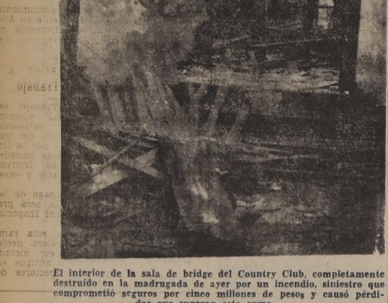
El interior de la sala de bridge del Country Club, completamente destruido en la madrugada de ayer por un incendio, siniestro que comprometió seguros por cinco millones de pesos y causó pérdidas que superan esta suma
