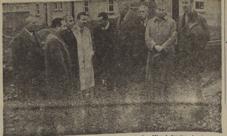
En la inauguración de la Población de Obreros Municipales de San Miguel, funcionarios de la Caja de la Habitación, después de visitar las dieciséis casas ya construidas, cambian ideas con los miembros de la Corporación Edificadora. Entre ellos: el Alcalde, señor Aravena; los regidores señores Pedro Alarcón, Moisés Bravo y Juan B. Moya, y los funcionarios de la Caja, señores Eduardo Mitcheo, Arturo Leyton, Ernesto Orellana, Arturo Ríos, José M. Toledo, José Luis Loyola y Romeo Techea. Los obreros, José Sáez y Manuel Castro, fueron los primeros agraciados con casas ya concluidas. Los obreros, José Sáez y Manuel Castro, fueron los primeros agraciados con casas ya concluidas, por haber obtenido el más alto puntaje en la clasificación hecha entre el personal.
