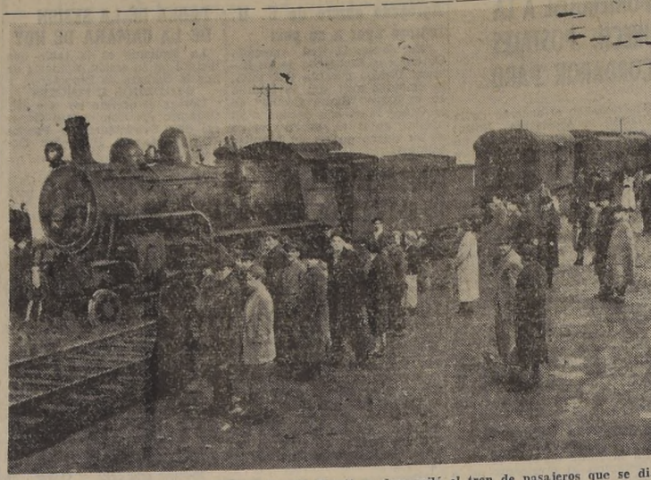
A escasos 500 metros de la Estación de Puerto Montt se descarriló el tren de pasajeros que se dirigía a Osorno, Saltaron de vía, la locomotora y la carboxera. Las últimas fuertes lluvias mitigaron la resistencia del terreno, donde se hallan asentados los rieles, determinando así el accidente. Por fortuna no hubo desgracias personales que lamentar. Fue, en verdad, una escapada providencial la de los pasajeros, ya que la vía se halla extendida en un terreno cortado a pico, junto al mar. Todo el convoy pudo haberse precipitado al abismo. (SCHMAUK, Corresponsal).
