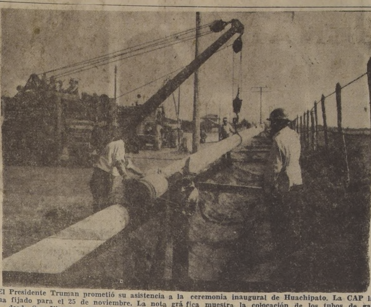
El Presidente Truman prometió su asistencia a la ceremonia inaugural de Huachipato. La CAP ha fijado para el 25 de noviembre. La nota gráfica muestra la colocación de los tubos de gas desde San Vicente a Liriquén. Este fue uno de los primeros beneficios que prestó Huachipato
