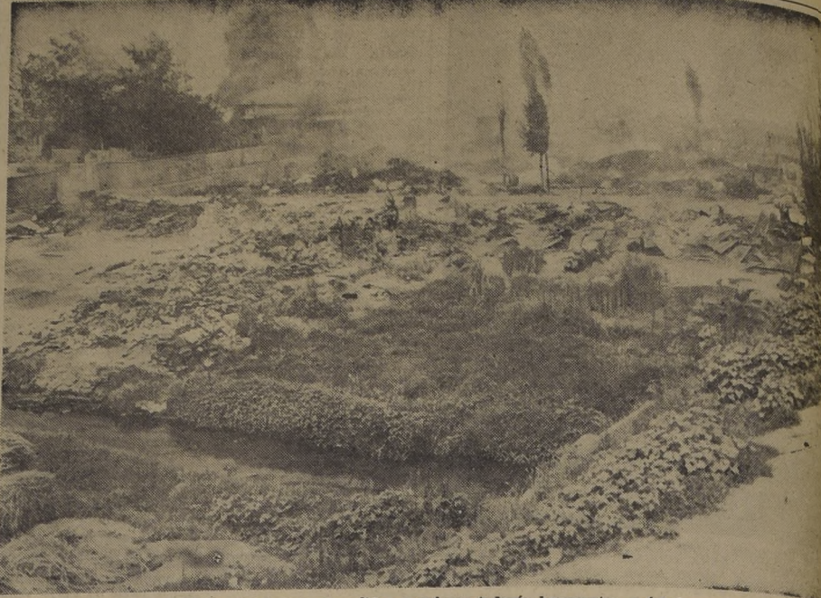
COREA DEL SUR.— Edificios totalmente demolidos y ruinas todavía humeantes, y árboles semidestruidos forman paisaje de un amanecer en un campo de batalla. Este es un pueblo coreano del Sur que fue bombardeado. Por aquí avanzaron las tropas norteamericanas en un avance en grande escala.— (FOTO ACME).
