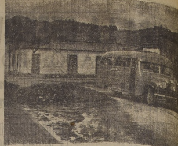
En esta esquina, que forman las calles El Salto y Valdivieso, hace varios meses profundos hoyos, para realizar trabajos de alcantarillado. Aún no ha sido reparado el tránsito, los montones de tierra que se han formado entorpecen el tránsito, obligando a los vehículos a hacer un peligroso zig zag. Urge que las autoridades competentes tomen del caso para poner término a esta anomalía.
