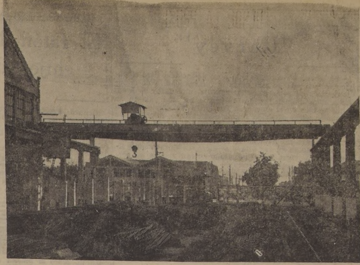
PUENTE GRUA PARA MAESTRANZA DE SAN BERNARDO. — Durante la fiesta realizada ayer en la Maestranza de San Bernardo, con asistencia de S. E. el Presidente de la República, se efectuó la inauguración de un puente rodante para grúa de 15 toneladas construido para esa maestranza por "Socometal".— El puente rodante para grúa fué construido totalmente de planchas dobladas y soldado al arco eléctrico. Sus características, son: Luz (distancia entre eje de rieles) 23.45 mts; longitud máxima del puente 23.79 mts.; Ancho máximo del puente 4.58 mts.; altura de la viga al centro, (incluido riel), 1.32 mts.; potencia del motor de tracción 36 HP. y velocidad de traslación cargado 2 metros. En el grabado, un aspecto del puente rodante, cuya construcción e instalación ha constituido un nuevo triunfo para "Socometal" y sus técnicos.
