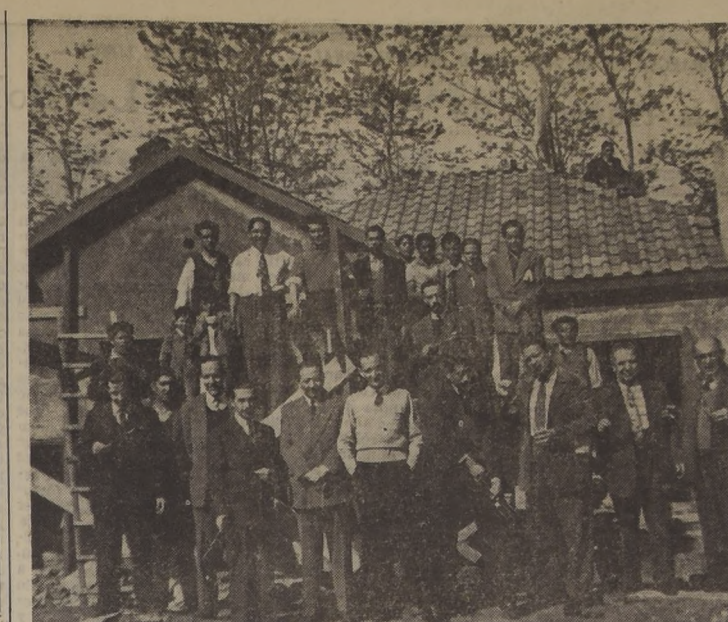
CELEBRAN LOS "TIJERALES". El sábado último se llevó a efecto la tradicional celebración de los "tijerales" de un edificio que construye el ingeniero señor Gregorio Paredes Meza...
