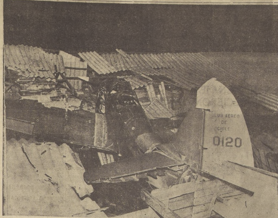
AVION SE ESTRELLÓ EN BODEGA DE MATERIALES.— Esta espectacular fotografía da una idea de la magnitud del accidente aéreo ocurrido en las últimas horas de la tarde de ayer, en una población obrera que se construye en Ochagavía. El avión, pilotado por Guillermo Phillips, se estrelló contra una bodega, quedando incrustado en un castiño de madera. El aviador y su acompañante sólo lograron salvarse gracias a un milagro, tras el rudo aterrizaje.
