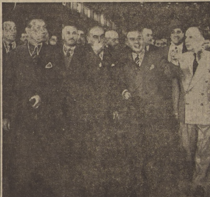
DE VISITA EN LAS USINAS. — El Primer Mandatario, acompañado de los Ministros de Economía y Relaciones, señores Benjamín Claro y Horacio Walker y del señor Roberto Vergara, gerente de la Compañía de Acero del Pacífico, admiró las modernas instalaciones de Huachipato.
