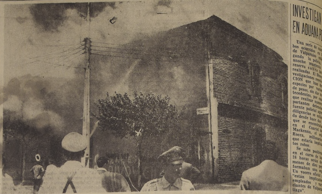
INCENDIO EN EL MOLINO.—Esta fotografía da una idea del incendio que destruyó gran parte del molino La Estampa, ubicada en Vivaceta. El humo tapó casi todo el antiguo edificio, mientras los bomberos se veían impotentes para luchar contra las llamas por la escasa presión de las mangueras.
