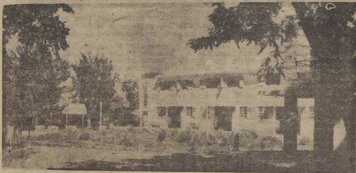
Pabellón moderno de las Termas de Catillo. Fué la única parte de la edificación que quedó intacta después del gran terremoto de 1939.
