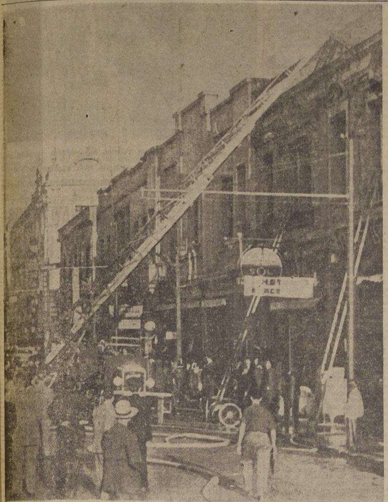
Unicamente la fachada del antiquísimo Hotel "Barcelona" quedó en pie, al término del incendio que produjo pánico en el barrio Estación Central. Este aspecto muestra la acción de los bomberos por la Alameda, tratando de evitar la propagación del fuego, que también produjo serios perjuicios en unos baños turcos, ubicados a un costado.
