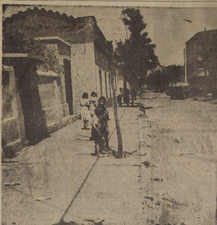
CALLES PROSCRITAS POR EL DEPARTAMENTO DE ASEO. — Hay calles en las cuales ya la gente que vive en ellas se cansó de colocar el tarro basurero en espera del camión o carrerón que la recoja. Preferían, una vez a la semana, ir a arrojarla a un canal cercano o a un sitio erizo. Esto ocurre en la calle General Gana, a la que muestra la fotografía a las 13 horas, cuando de papeles y con pasto creciendo en las cunetas. En esos instantes se hacía la recolección de basura en el barrio; pero, como se puede advertir, el carrerón pasó por allí y va saliendo por San Francisco, ya de regreso.
