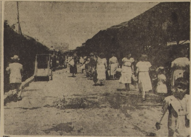
EL MATADERO MUNICIPAL, VERGUENZA D E SANTIAGO. — Mientras se abuncia que no hay dinero para terminar el Matadero Modelo "Lo Valledor", la ciudad continúa manteniendo la verguenza del Matadero Municipal, antro de especuladores, y donde la cuarta parte de la población metropolitana se abastece de productos alimenticios, en medio del más terrible desaseo. El grabado muestra la "calle" central del Matadero, que parece un aspecto de una población "callampa".
