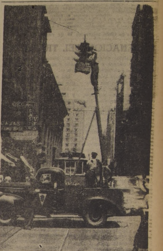
Un semáforo cuyas lámparas se apagan, da motivo a un serio problema de tránsito, y obliga a la inmediata intervención del carabnero, para solucionar el percance. En el grabado, en Agustinas esquina de Bandera, técnicos del Departamento del Tránsito reparan un señalizador cuya luz verde quedó ciega por haberse quemado la ampolla. En la Alameda, donde son automáticos, la situación es más complicada, porque entre San Antonio y Plaza Baquedano el peatón no tiene refugios donde guarecerse y queda a merced de los automovilistas.
