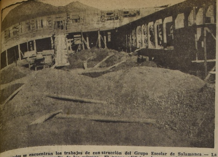
Más avanzados se encuentran los trabajos de construcción del Grupo Escolar de Salamanca.—La gráfica muestra el desarrollo de los mismos. El nuevo edificio colma una vieja y sentida aspiración de los habitantes de la localidad.
