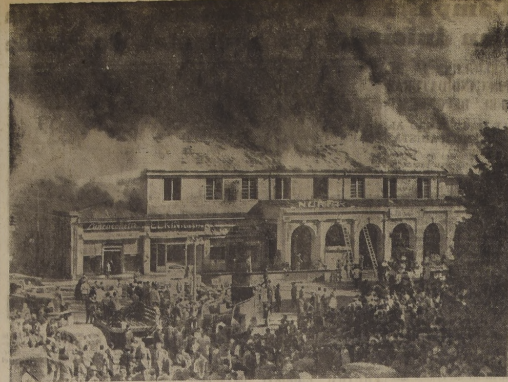
INCENDIO EN CONCEPCION.-Grandes llamaradas abrasan el ruinoso edificio del Portal Cruz de esta ciudad, que el jueves pasado quedó destruido por el violento incendio que se declaró en el restaurante "Nuria".
