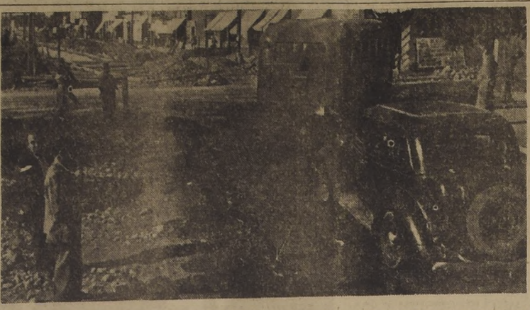
Mientras los trabajos avanzan con lentitud desesperante, la principal arteria de entrada de Santiago por el sur ofrece el aspecto de una ciudad bombardeada o que ha sufrido los efectos de un terremoto.
