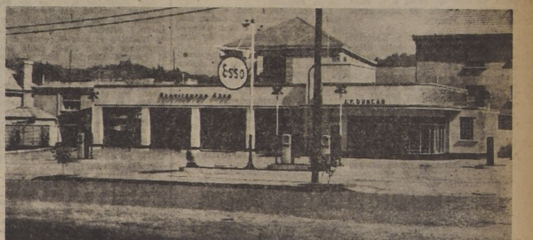
Aspecto exterior del Servivcentro Esso de Providencia
