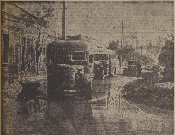
ORTE Y SUR DE SANTIAGO, EN IGUAL ESTADO DE ABANDONO. — Hace seis meses se iniciaron trabajos de alcantarillado en la calle Constantino, en el barrio ultra Mapocho. Comenzaron las obras, se destruyó el pavimento, fueron abiertas zanjas, y después, por falta de personal y obreros, quedaron paralizadas. De vez en cuando se hace algo. Pero el estado deplorable en el que quedó la calle causa desorden y congestión del tránsito. Se han formado también grandes lagunas, como la que muestra el grabado. En el extremo opuesto de la ciudad, en Gran Avenida, la situación es peor, debido, igualmente, a obras inconclusas que han despedazado vías de intensa circulación. Ambos ejemplos son elocuentes para demostrar el triste abandono en que se encuentran las autoridades a los sectores suburbanos, aunque, a decir verdad, algunas calles ubicadas más al centro no tienen mejor suerte.
