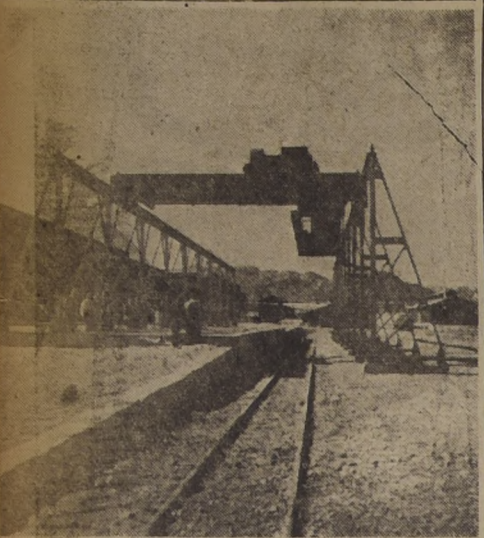
Instalaciones de descarga para carros de ferrocarril. Los carros descargan por este puente-grúa, que tiene un capacity de una tonelada. Los minerales son vaciados a tolvas subterráneas, ubicadas al lado de la vía férrea.
