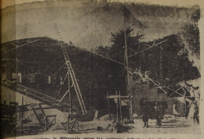
Esta foto puede apreciarse la diferencia entre las antiguas tribunas del Club Hípico, de Peñuelas, y las que están próximas a ser terminadas, las que ofrecerán amplias comodidades al público.
