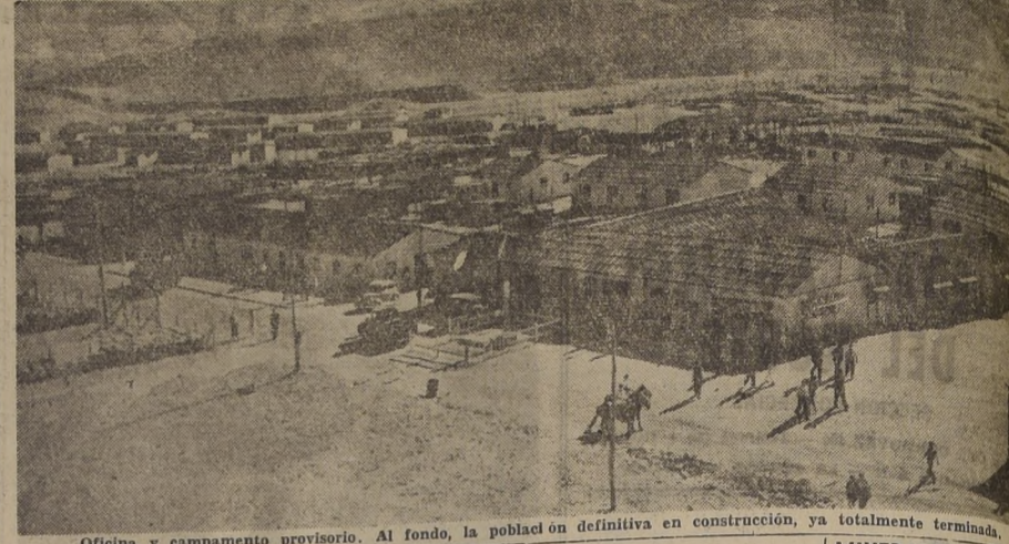
Oficina y campamento provisorio. Al fondo, la población definitiva en construcción, ya totalmente terminada.
