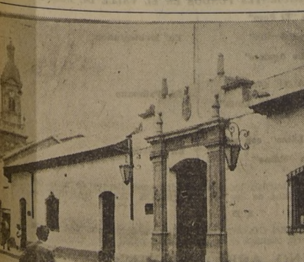
Este edificio de estilo colonial, característico de la construcción serenense, funciona la Sociedad Agrícola del Norte.
