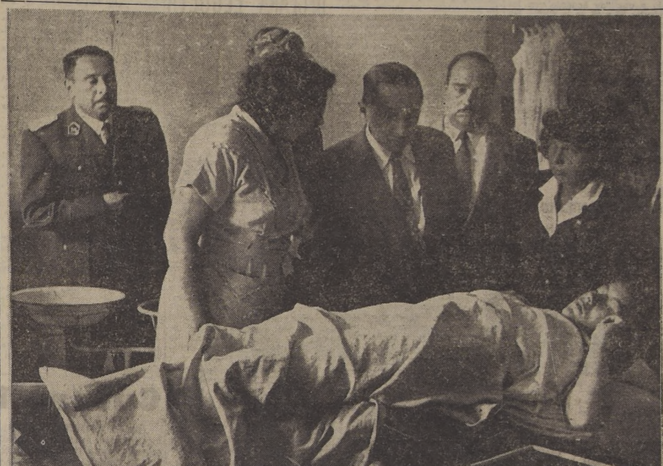
DERRUMBE EN EL LICEO N.º 4: 20 ALUMNAS HERIDAS.— Veinte alumnas resultaron heridas, tres de gravedad, al derrumbarse una escala, en el viejo edificio del Liceo N.º 4 de Niñas.
